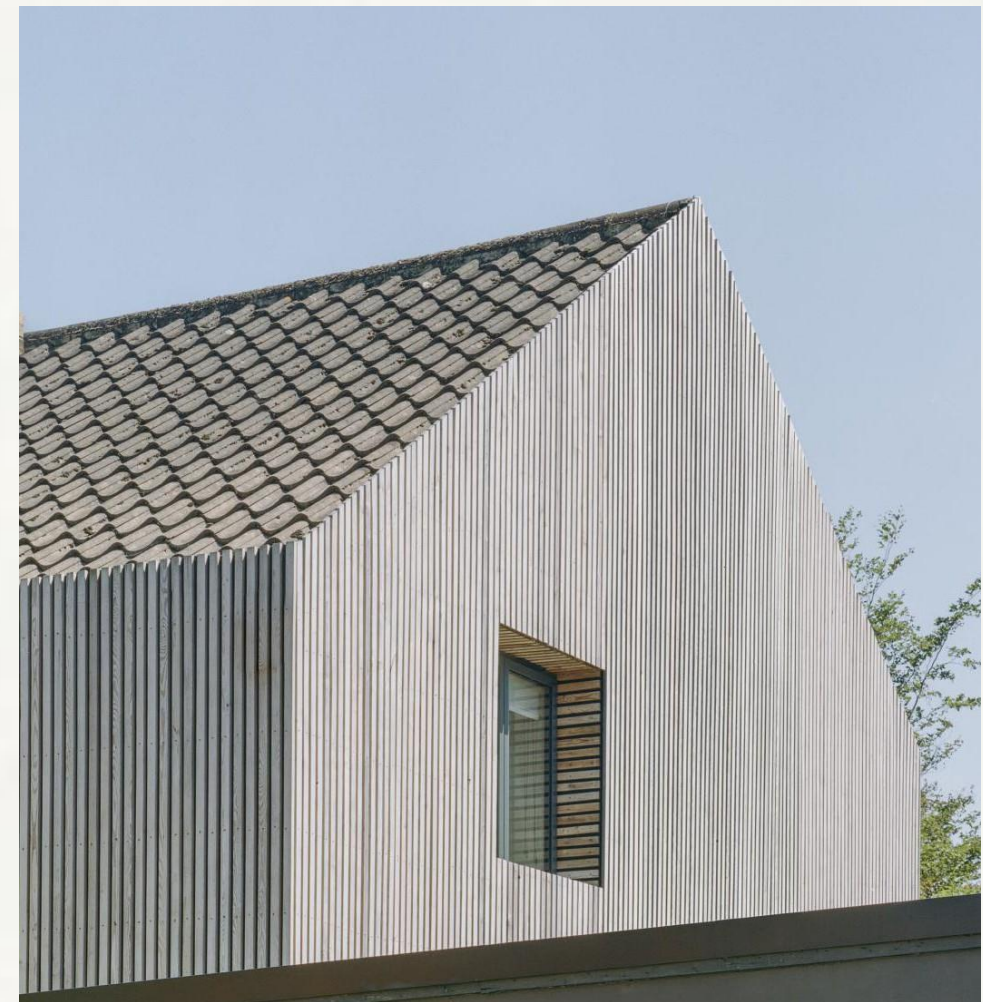
Strakke detaillering: aansluiting houten gevel op dakpannen
