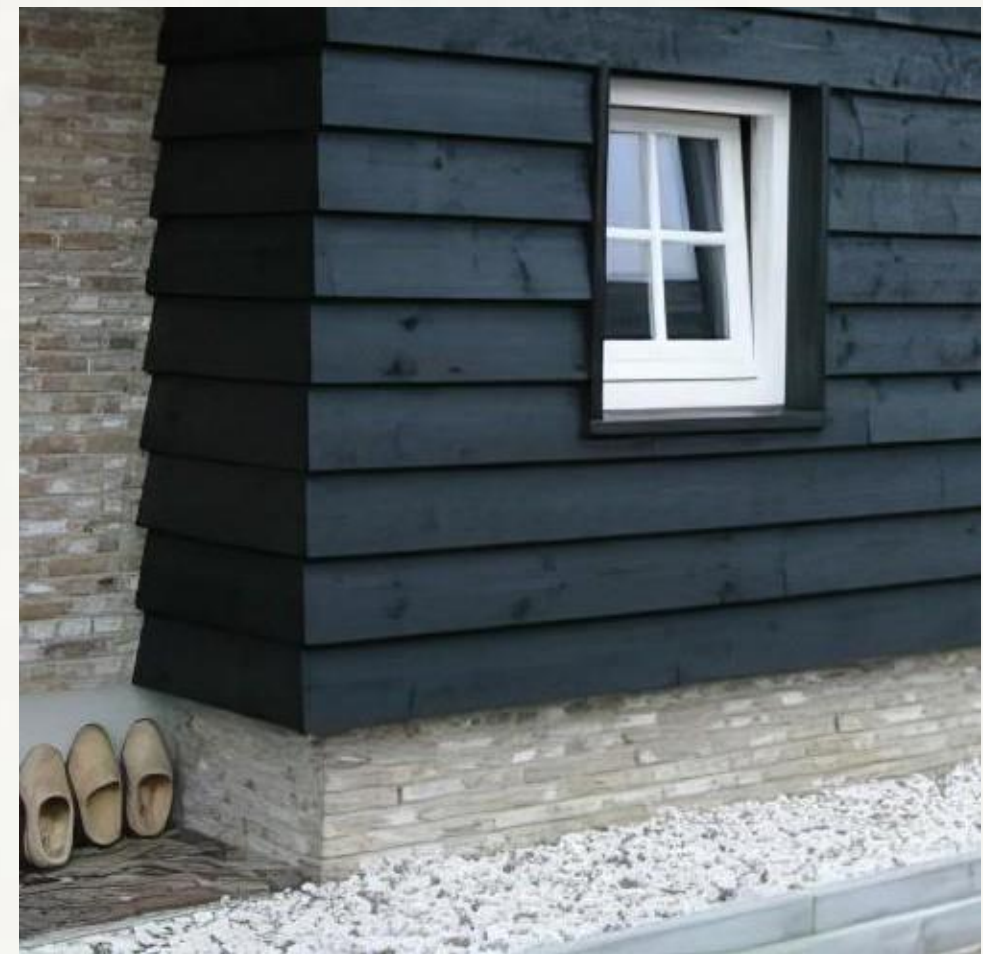
Eigentijdse interpretatie van de schuur typologie: metselwerk plint met een houten gevel
