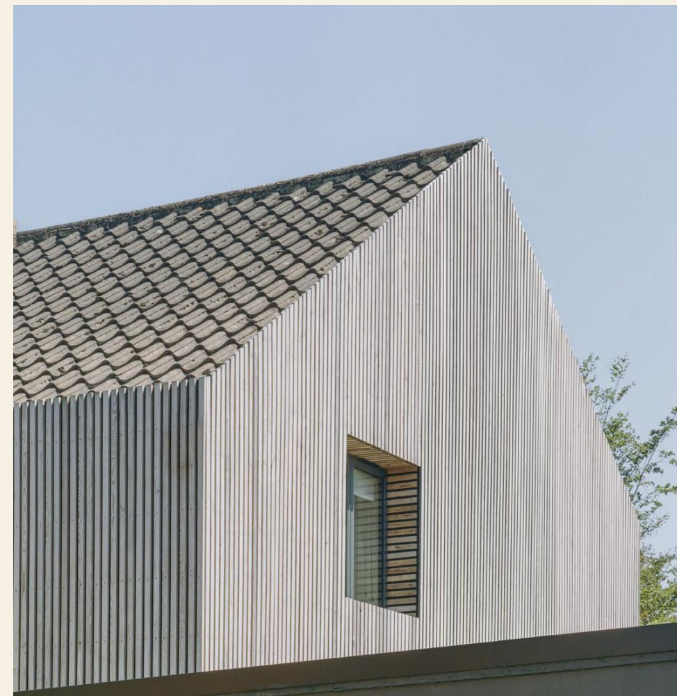
Strakke detaillering: aansluiting houten gevel op dakpannen
